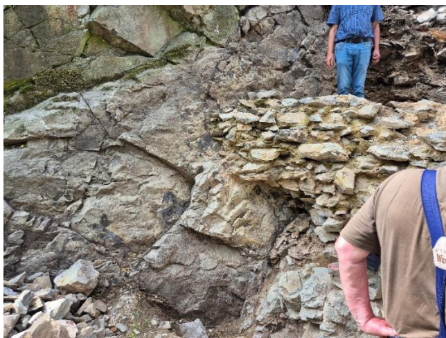
Narušené zdivo stěny, která je založena na skále před věží Místostarosta obce
