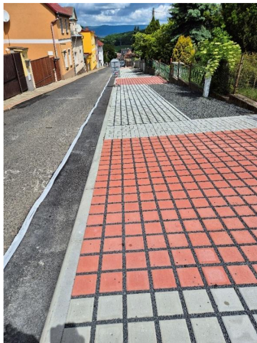
Opravená část místní komunikace
