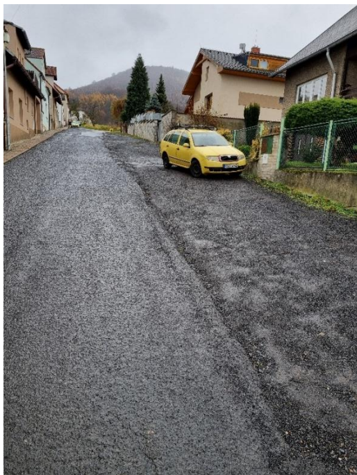
Stav před rekonstrukcí
